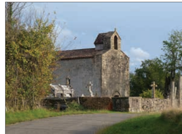
Eglise de Vielvic (MH) Source : L'Artifex 2018
