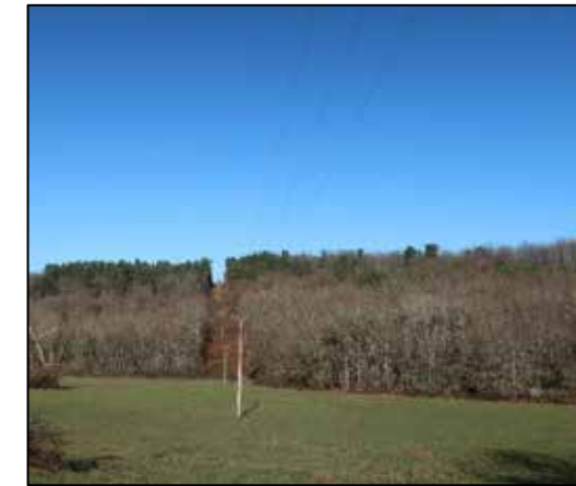
Ligne électrique sur le site d'étude Source : Artifex 2019
